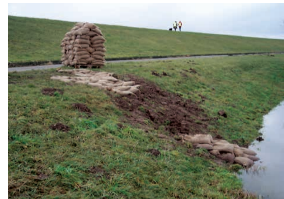
Elbhochwasser Januar 2011: Notverbau eines Bisamschadens im Außendeich-Bereich
