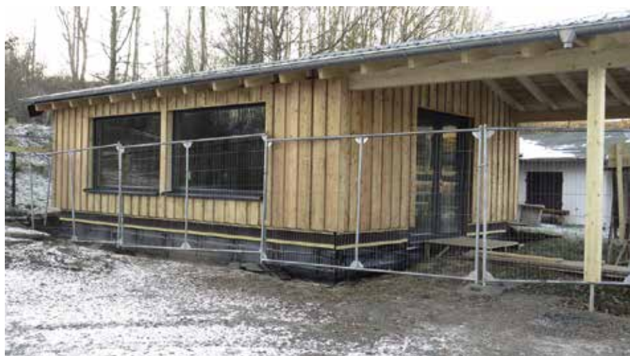
Aktueller Bauzustand Anfang Januar 2024
